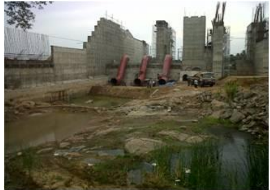
දැදුරු ඔය ජලාශයේ ඉදිකරන කුඩා විදුලි බලාගාරයට penstock නල 03ක් සාදා සවිකිරීම
